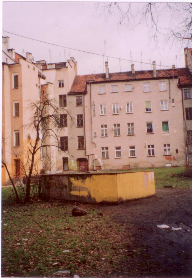
Fot. nr 2. Widok budynku (z częścią dachu pokrytą papą)w elewacji tylnej(zachodniej).
