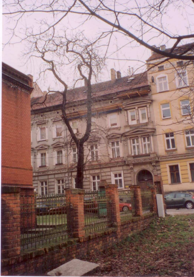
Fot. nr 1. Widok budynku z pokryciem dachu w elewacji frontowej(wschodniej).
